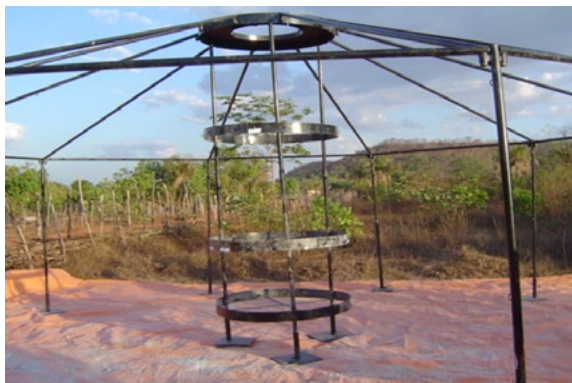
Imagem 44: Esqueleto metálico do secador solar – Foto: SDA
