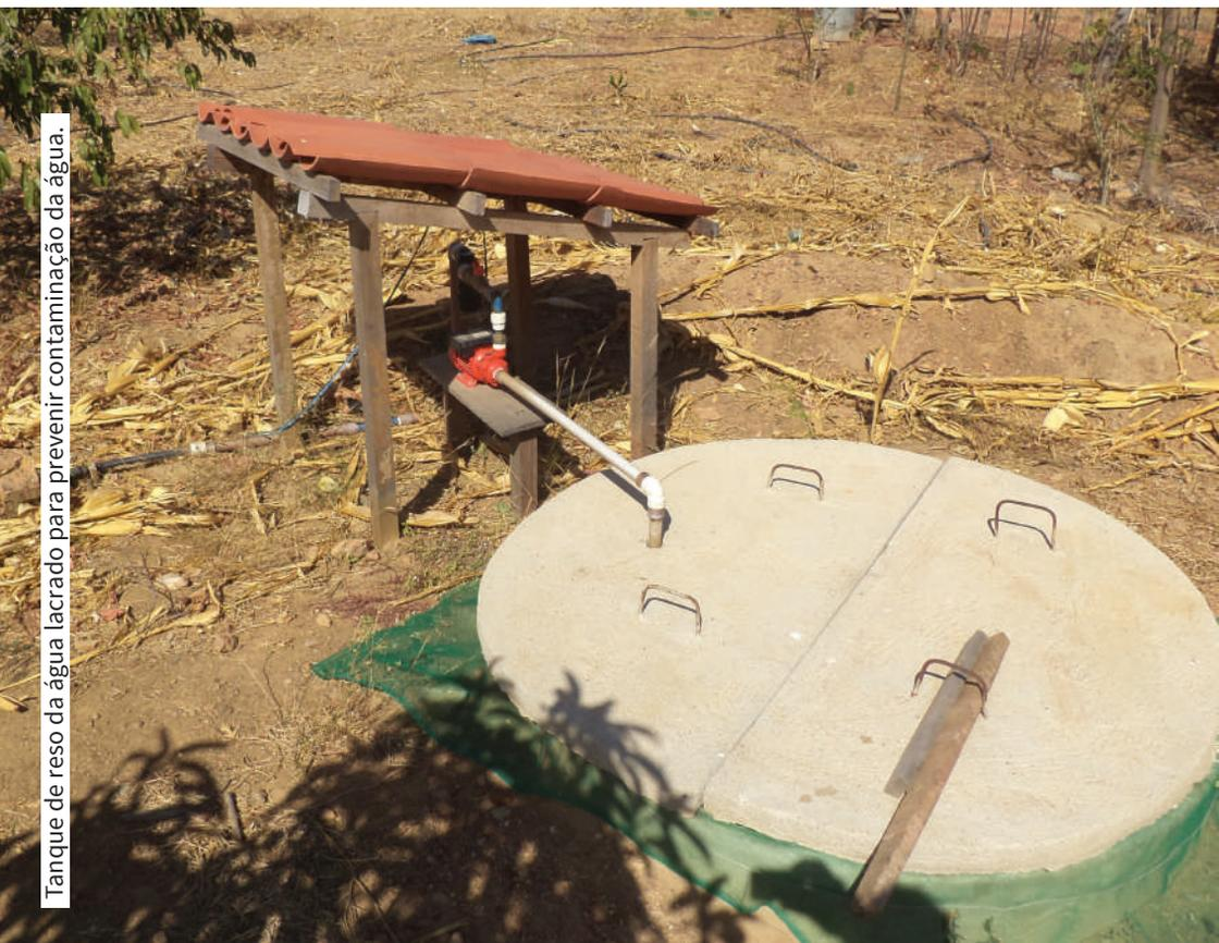
Tanque de resso da água lacrado para prevenir contaminação da água.
