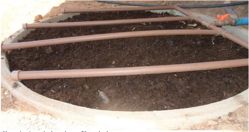
Chuveiro instalado sobre o filtro da água.
