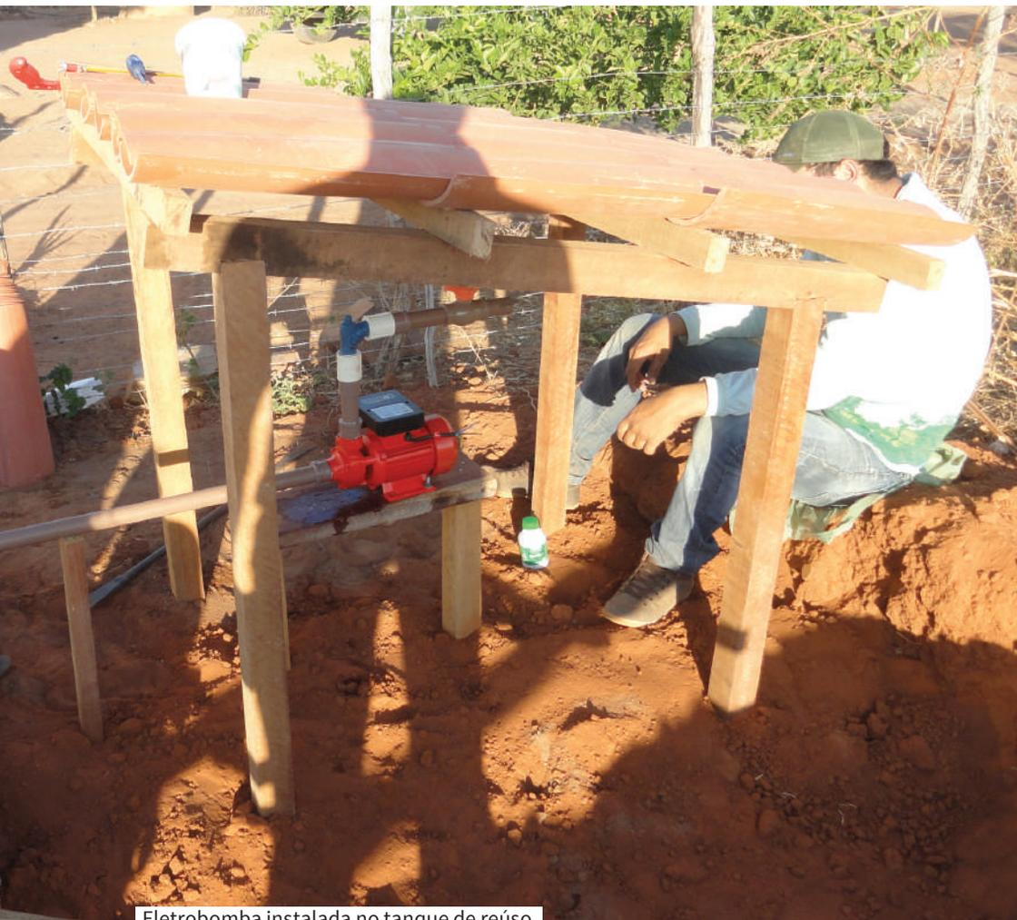
Eletrobomba instalada no tanque de reúso.
