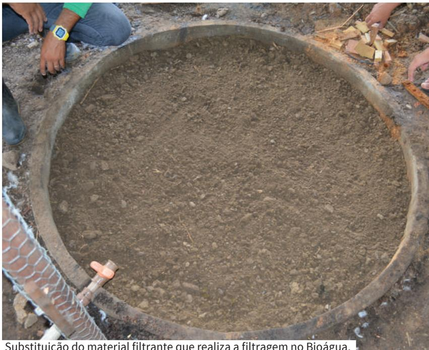
Substituição do material filtrante que realiza a filtragem no Bioágua.
