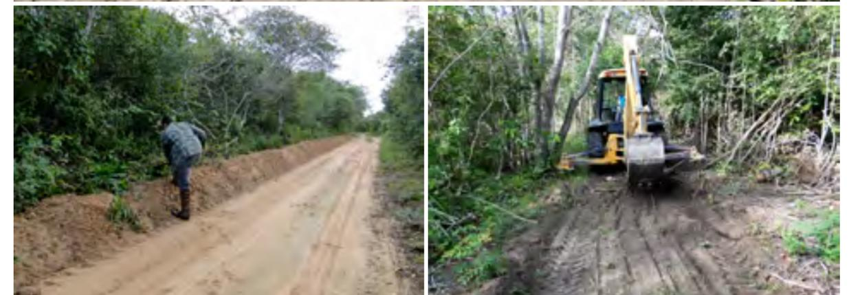
Abertura estrada gameleira – Realizada de forma manual para evitar retirada desnecessária de árvores e depois uso de máquina para retiradas de trocos e raízes.
